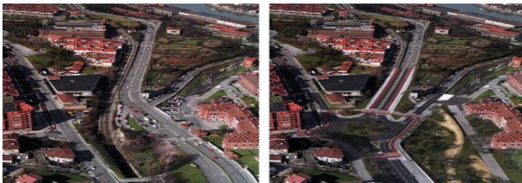
Antes y después de las obras en la Avenida de Montevideo y Castrejana
